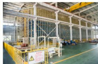
大型立体仓库
